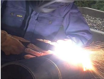
Entfernen der Schweißnaht
