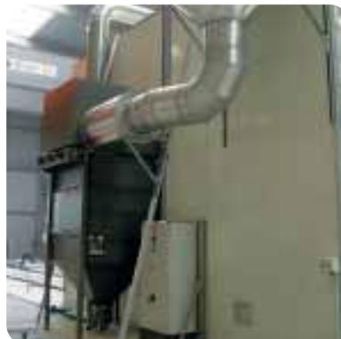
DUSTMAC Filtereinheit an Schleifkabine
