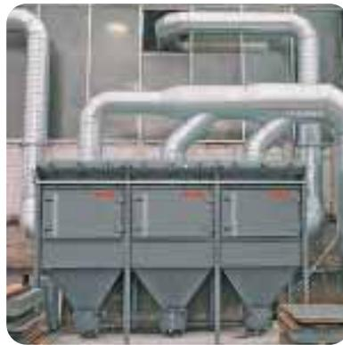
Modular aufgebaute Filtereinheit
