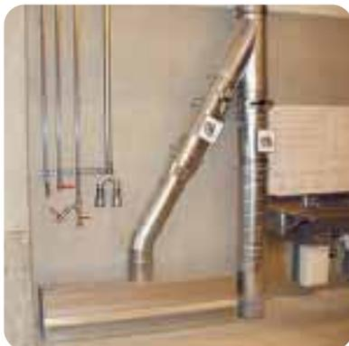
Stauberfassung durch spezielles Rohrleitungssystem
