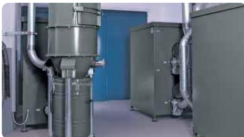
Zentrale Staubsaugereinheit mit zwei Seitenkanalverdichtern ausgestattet
