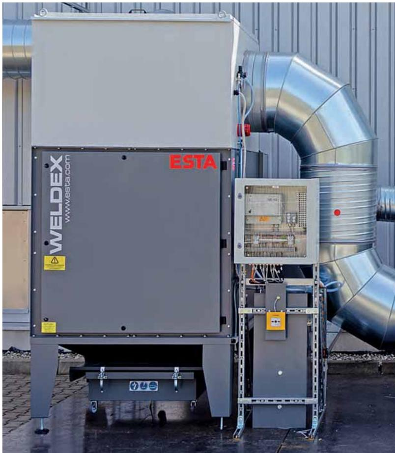
Zentrale Filtereinheit mit Löschanlage in einem Schweißrauch-Absaugsystem
