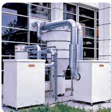
Absauganlage in Sonderlackierung im Freien aufgestellt
