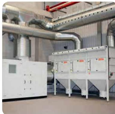
DUSTMAC Filtereinheit mit Absaug- und Zuluftventilator
