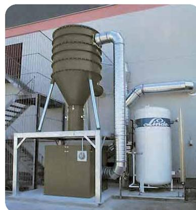
Filterzyklon auf einer Stahlkonstruktion
